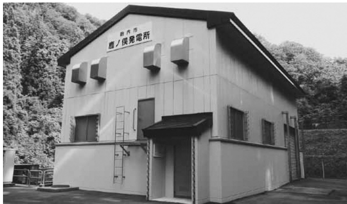
鹿ノ俣発電所
