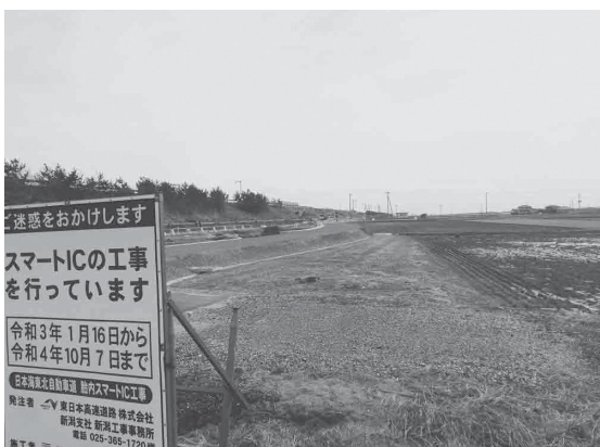
胎内スマートインターチェンジ工事現場
