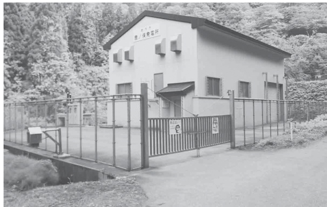
胎内市鹿ノ俣発電所
