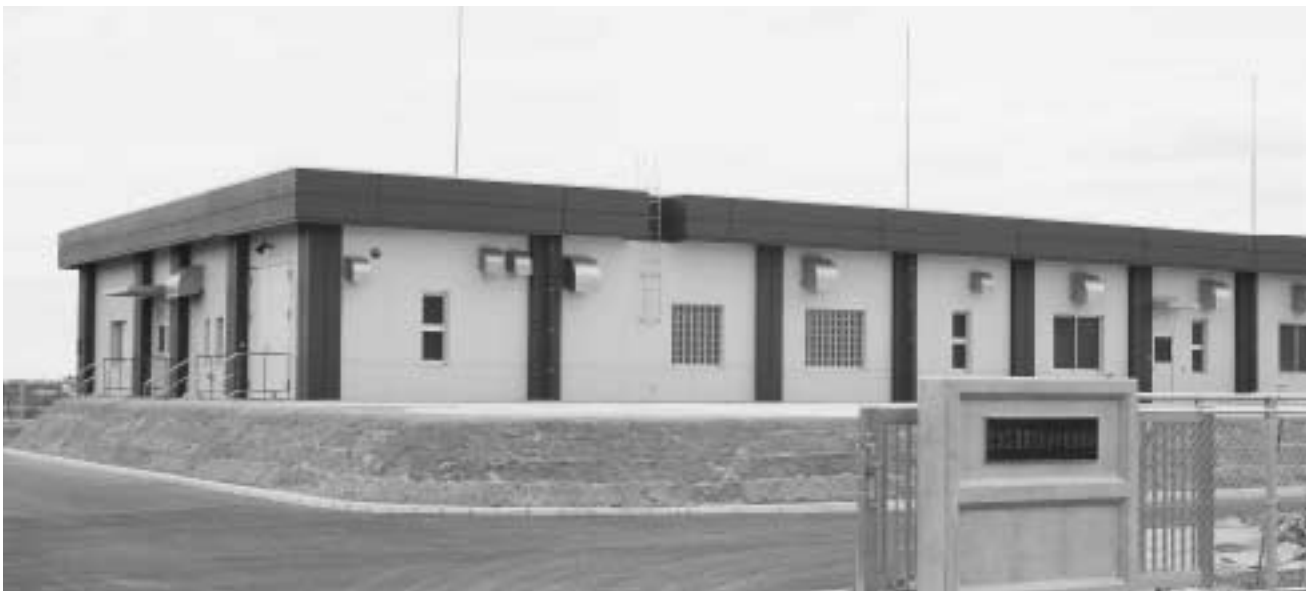
乙地区農業集落排水処理施設
