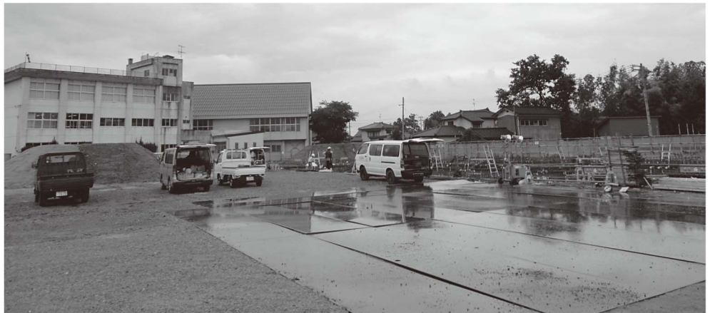
中条すこやかこども園 工事現場 (旧本条小跡地)
