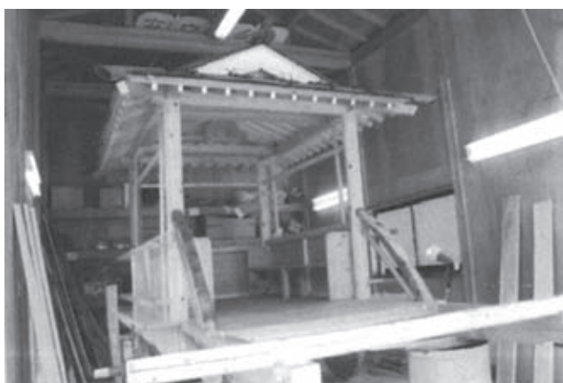
補助金を利用した山車の修繕
