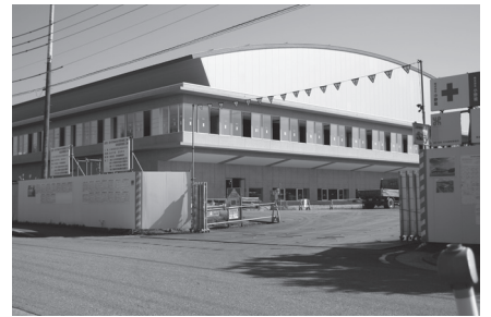
建設中の総合体育館
