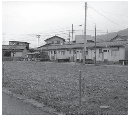
市営黒川住宅を取り壊した更地
