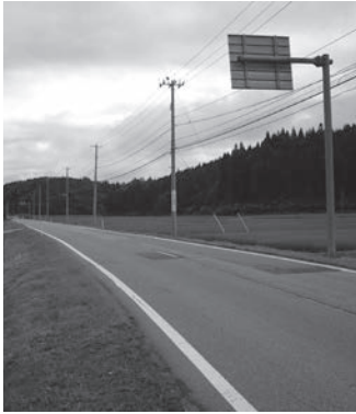
国道290号線坪穴付近
