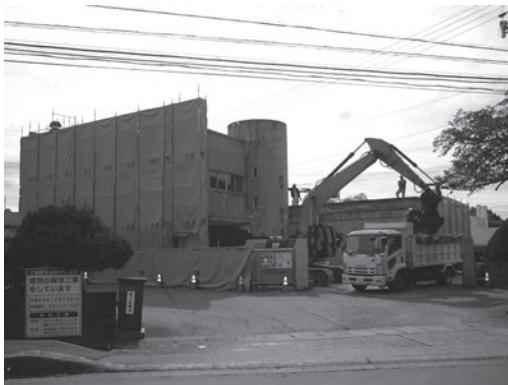
解体工事が始まった旧黒川健康センター
