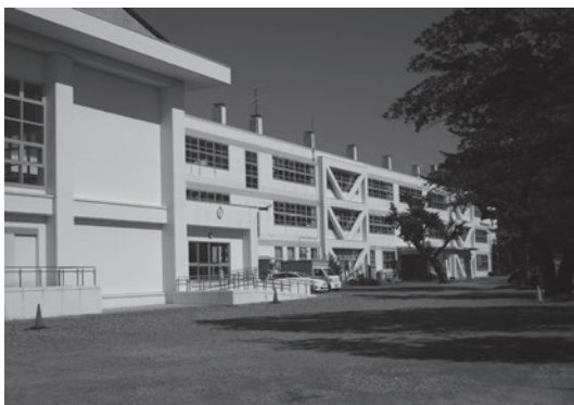
耐震補強が完了した小学校
