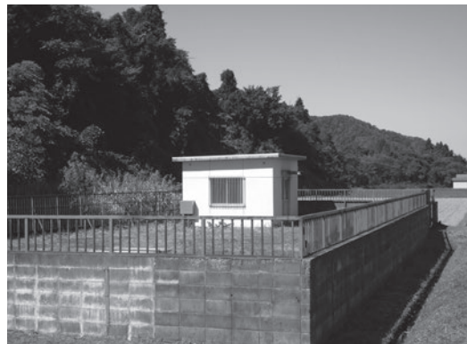
新胎内温泉のポンプ小屋
