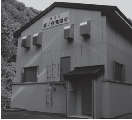
鹿ノ俣発電所
