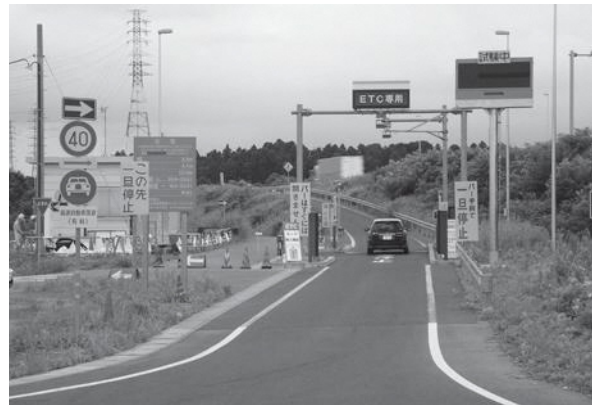
スマートインターチェンジ
