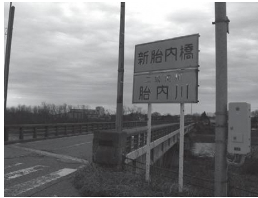
高畑地内の新胎内橋
