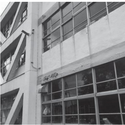
築57年経過した中条小学校
