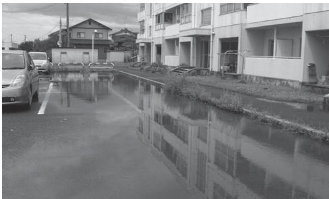
降水時に冠水状態の市営1号棟駐車場
