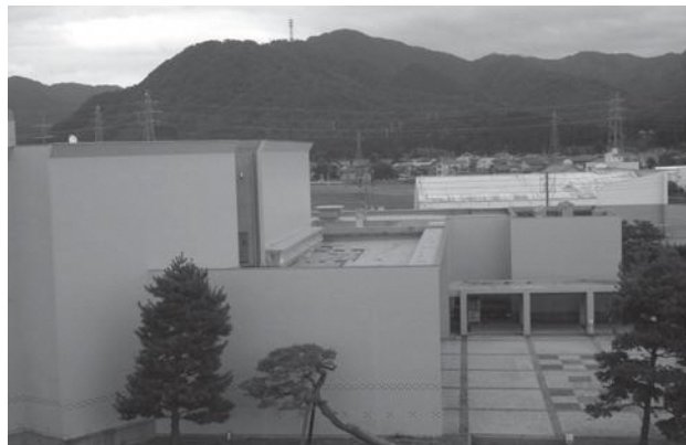
ブルーシートで屋上の応急処置を行う産業文化会館
