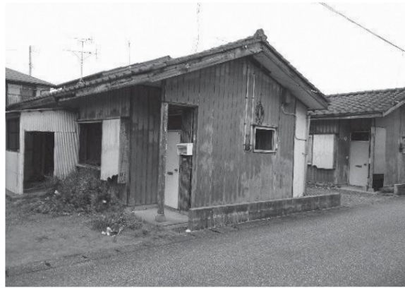
胎内市設住宅
