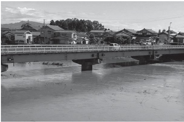
増水時の落堀川
