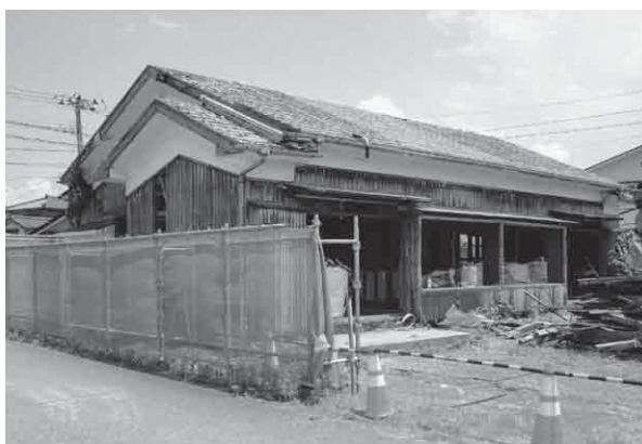
解体中の市設住宅（二葉町地内）
