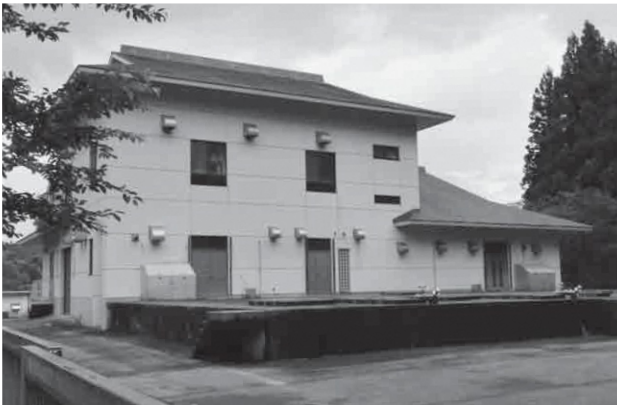
農業集落排水処理施設
