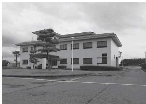
中条浄化センター
