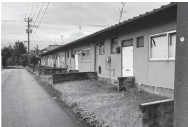
解体予定の市営住宅
