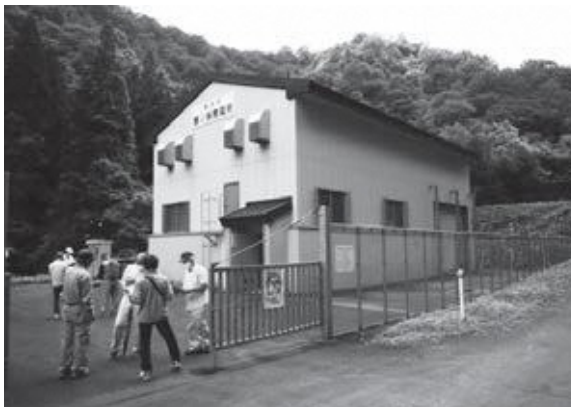
鹿ノ俣発電所
