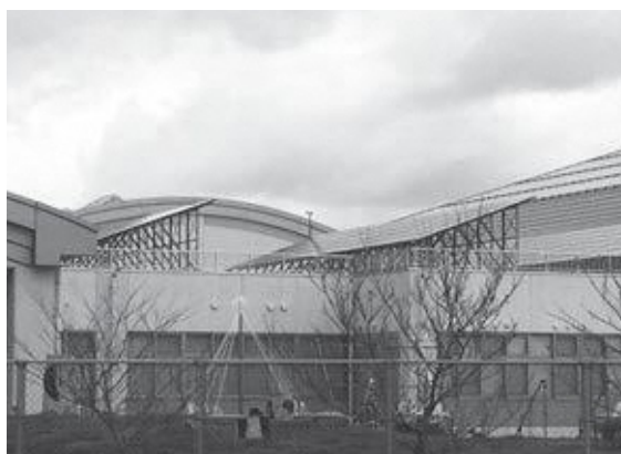
胎内小学校の太陽光パネル
