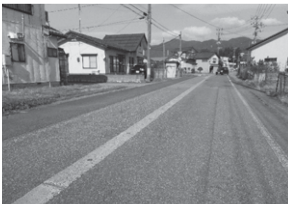
黒川駐在所前の消雪設備
