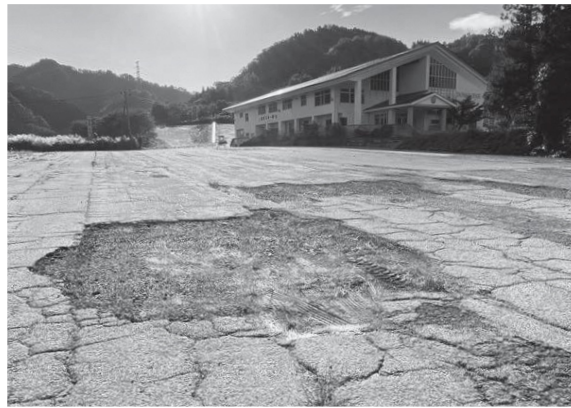
胎内スキー場 第1駐車場
