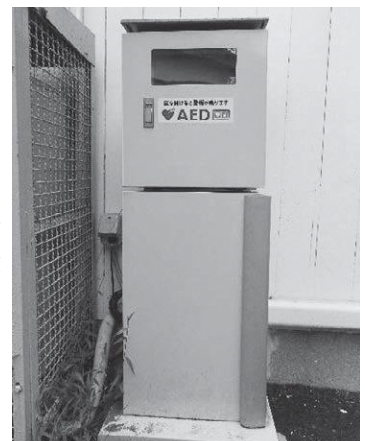
屋外に設置しているAED
