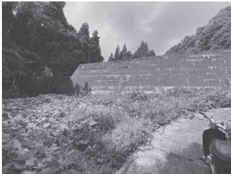
坂井地内の治山堰堤
