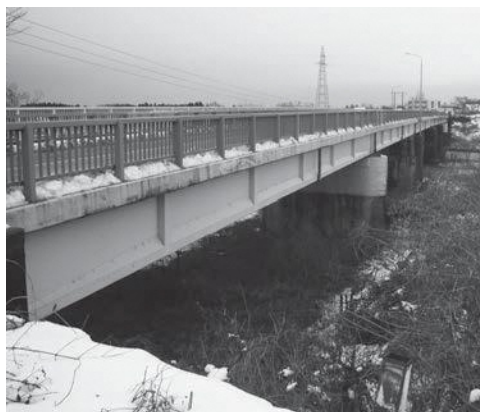
胎内川の橋梁
