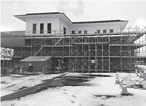
建設中のし尿等下水道投入施設
