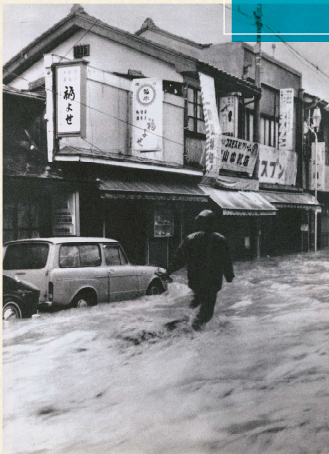
8.28 羽越水害(本町)
