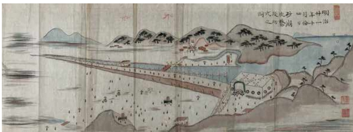
写真1-9 胎内川切り落し工事竣工式の絵 明治21（1888）年10月14日
