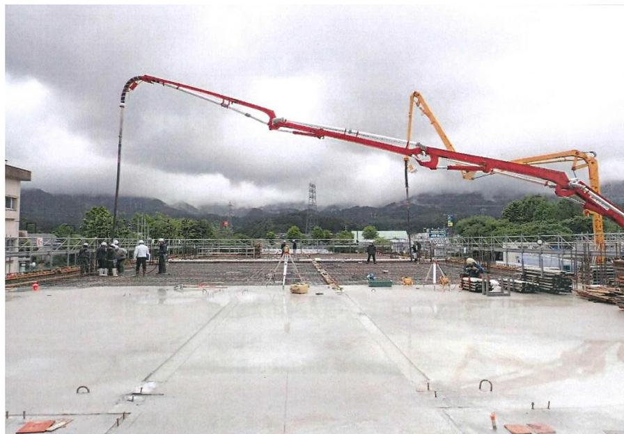
▲北校舎2階躯体コンクリート打設
