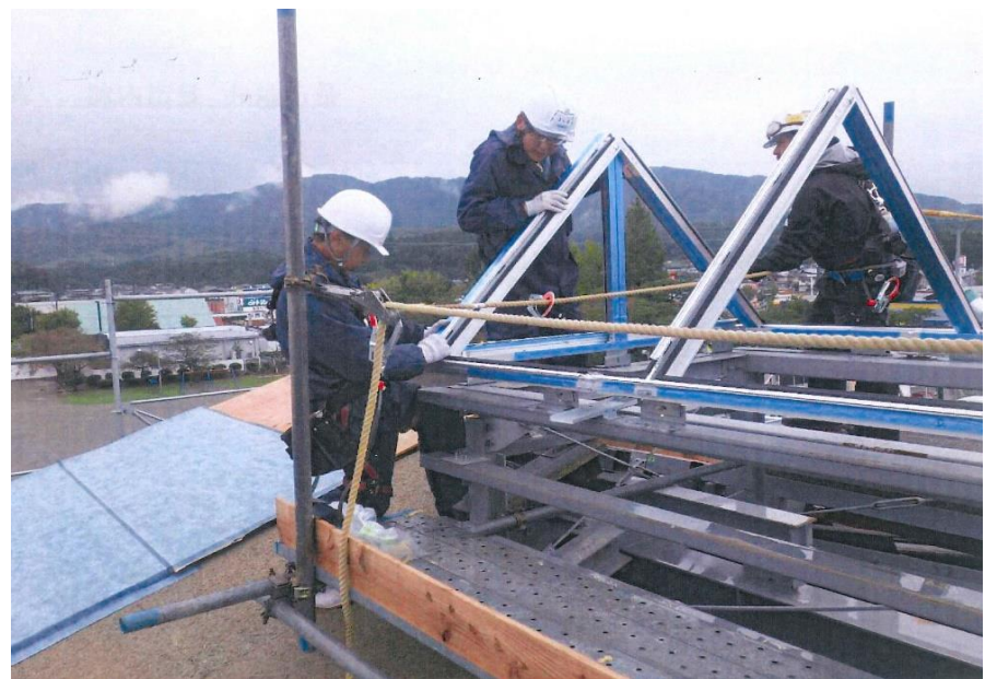
▲北校舎棟屋根トッライト取付
