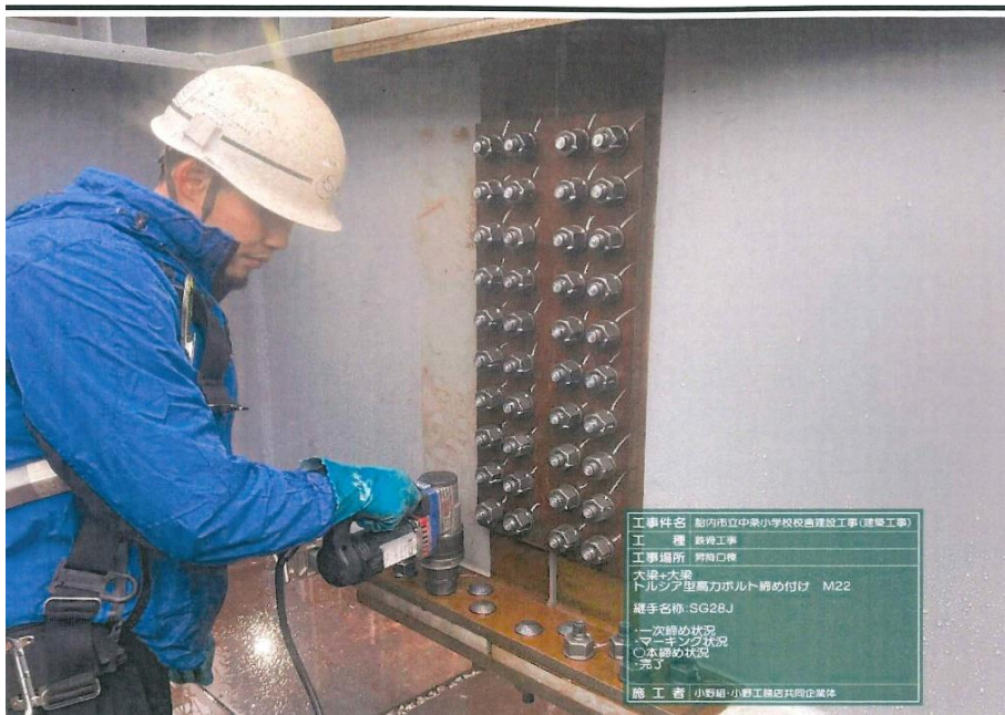
▲昇降口棟2階鉄骨建方ボルト締付
