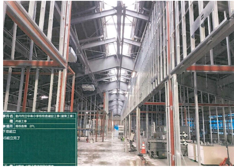
▲南校舎棟2階内装下地L.G. S組立
