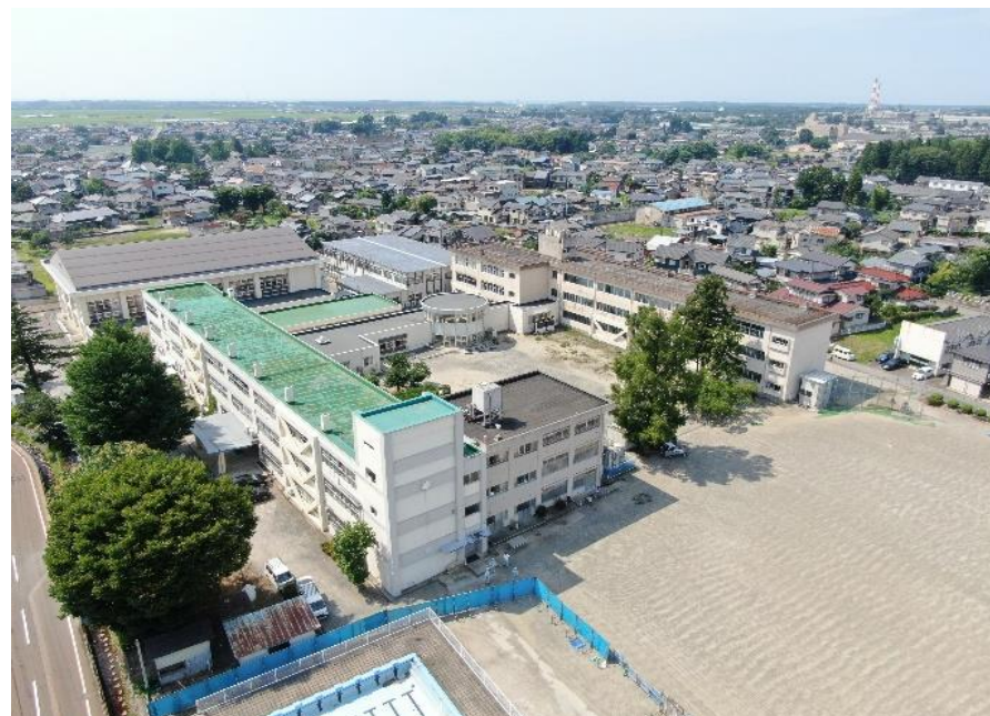
▲解体前 南東側全景
