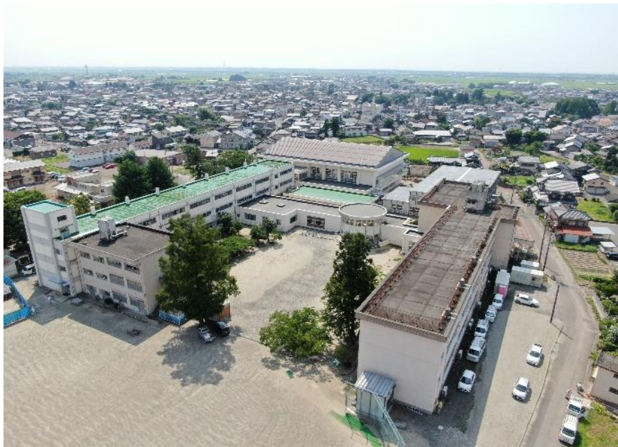
▲解体前 北東側全景
