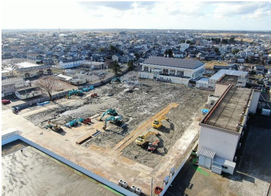
▲解体完了 北東側全景
