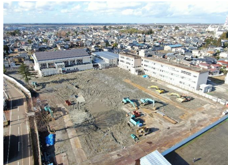
▲解体完了 南東側全景
