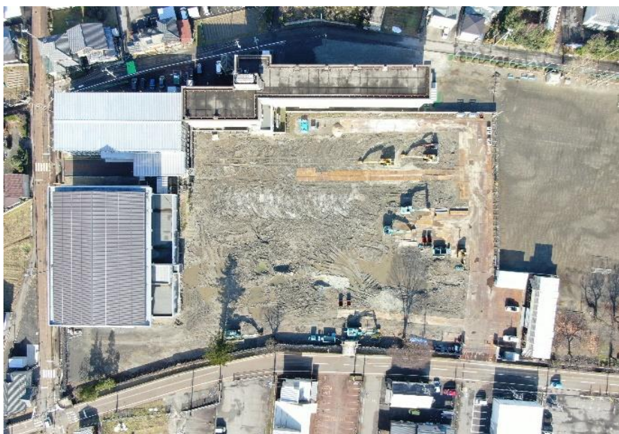
▲解体完了 全景
