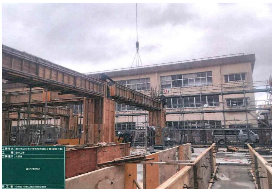
▲北校舎1階躯体鉄筋・型枠組
