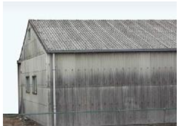
石綿含有スレート波板（屋根・外壁）
