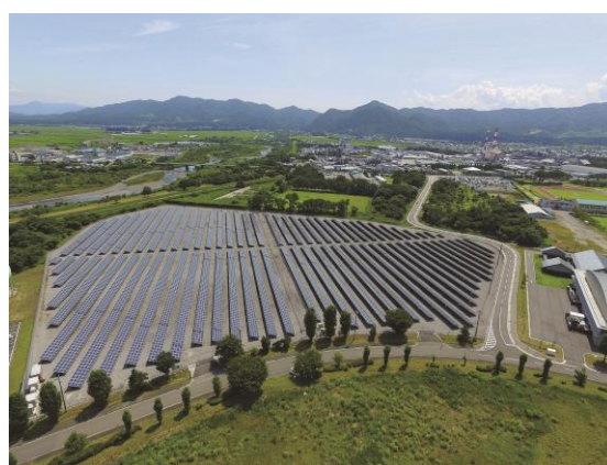
新潟中条中核工業団地内の太陽光発電施設
