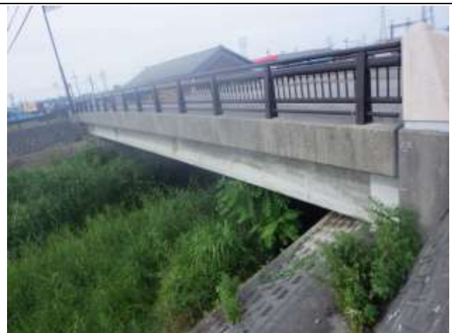
写真全景 (コンクリート橋) (関沢大橋)
