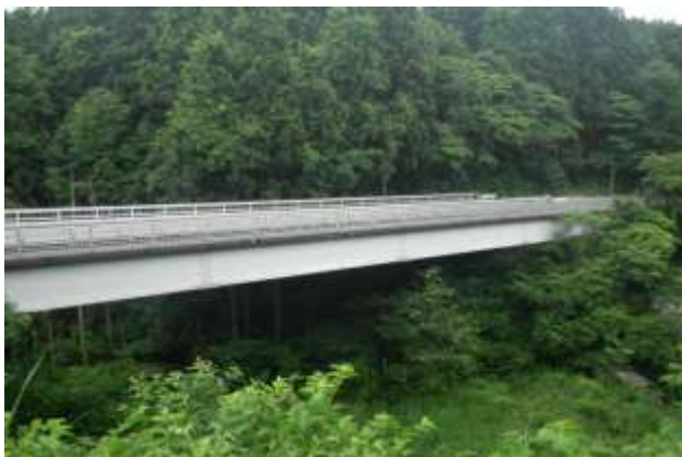
写真全景 (鋼橋) (波石大橋歩道橋)
