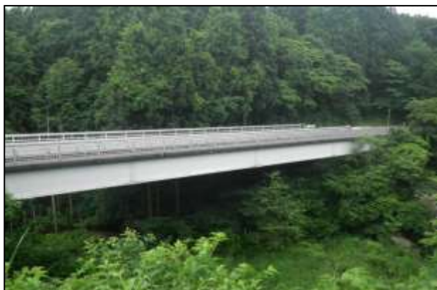
写真全景（鋼橋）
