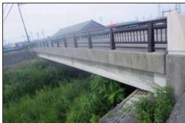
写真全景（コンクリート橋）
