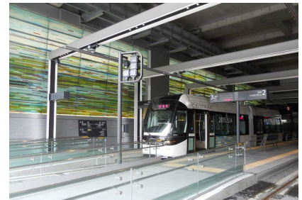
路面電車の富山駅高架下乗り入れ
