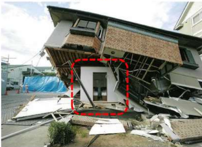
〔耐震シェルターの例〕
