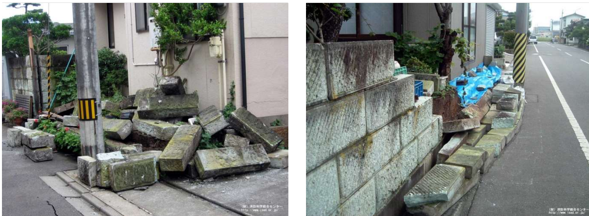
図 3-2 ブロック塀の崩壊による被害の状況
