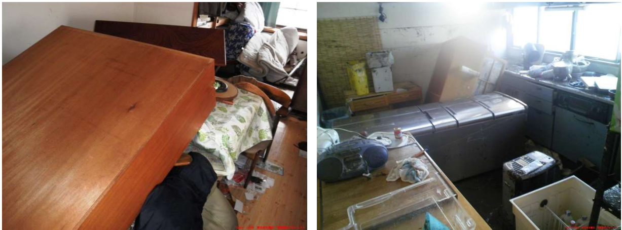
図 3-1 家具の転倒による被害の状況
