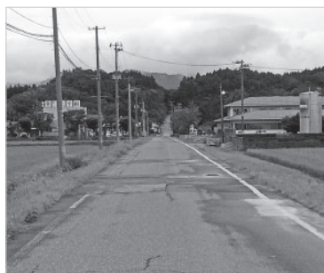
↑黒川・塩沢・蔵王線（令和元年）現在はアスファルト舗装され、塩沢・前山台集落児童が黒川小学校へ通う通学路となっています。
