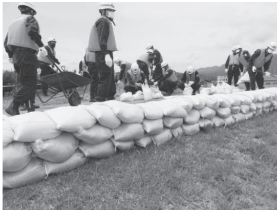
実践訓練（積み土のう工）を行う胎内市消防団
