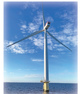
撮影：日本風力発電協会
